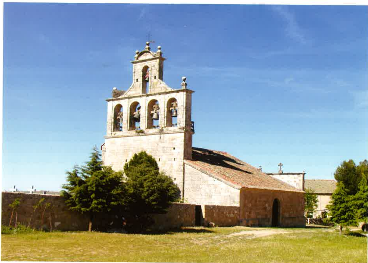
Vista del edificio desde el oeste
