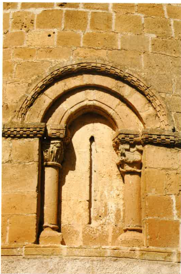
Ventana central del ábside
