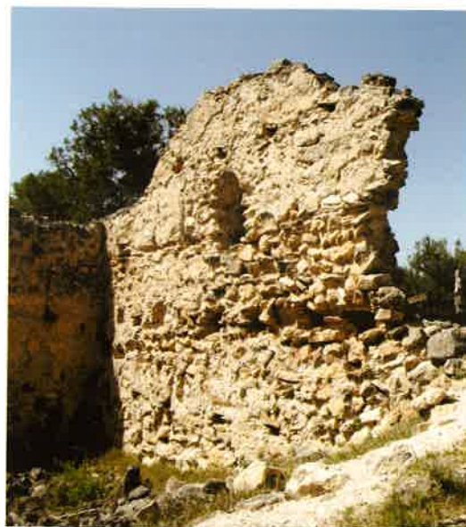
Vista del hastial occidental
